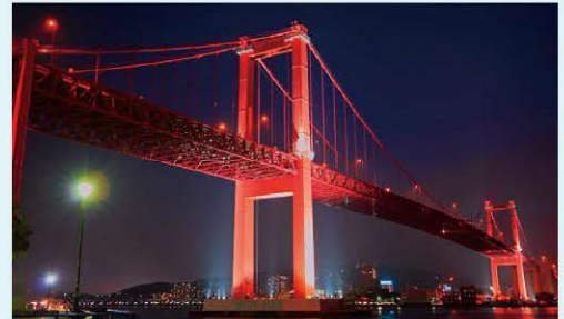
施工実績「若戸大橋のライトアップ工事」
